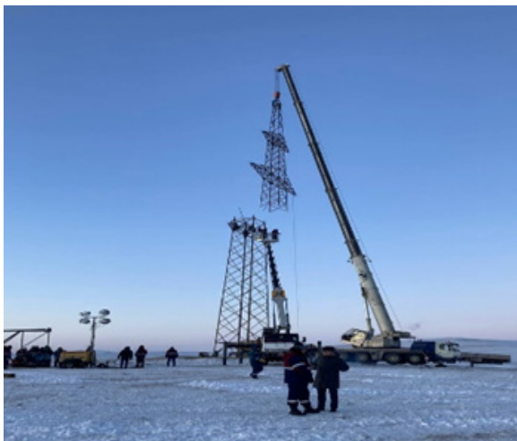
220 кВ-ын 203, 204-р шугамын тулгуур №68-д гэмтэл устгах, сэргээн босгох ажил
