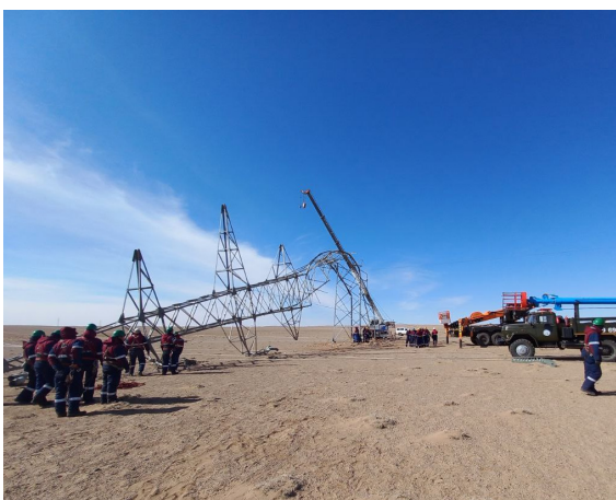
220 кВ-ын 215, 216-р шугамын тулгуур №32-д гэмтэл устгах, сэргээн босгох ажил
