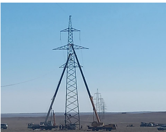
220 кВ-ын 215, 216-р шугамын тулгуур №32-д гэмтэл устгах, сэргээн босгох ажил
