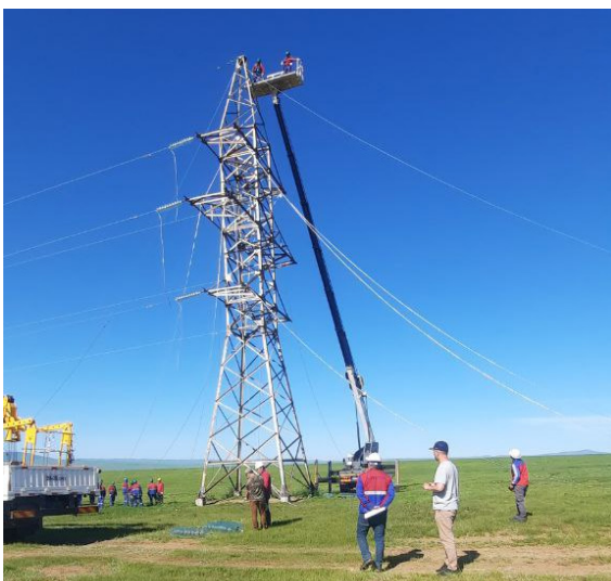
110 кВ-ын Хархорин-А, Б АШ-д гэмтэл устгах, сэргээн босгох ажил
