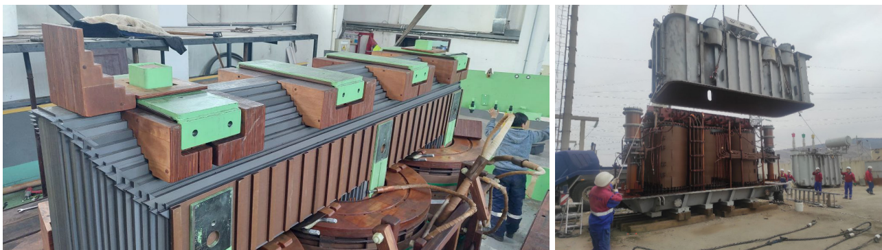
Хүчний трансформаторын бүрэн задаргаат их засварын ажил
