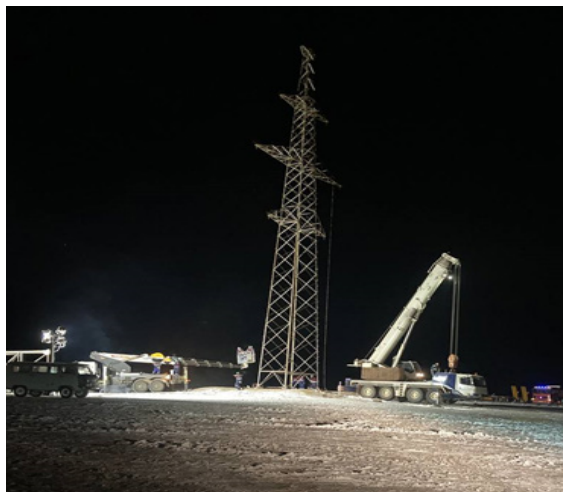
220 кВ-ын 203, 204-р шугамын тулгуур №68-д гэмтэл устгах, сэргээн босгох ажил
